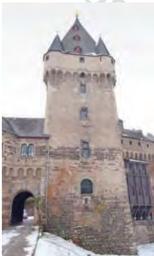
14 (links) Ehemaliger Torturm der Hauptburg in Hülchrath (2019). Links das neue Tor, im Turmsockel die vermauerte alte Toröffnung.
