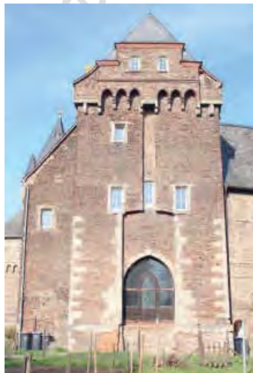
12 Ehemaliger Torturm der Vorburg in Hülchrath mit erhaltener Tor-durchfahrt und Führung für das Fallgitter (2019).
