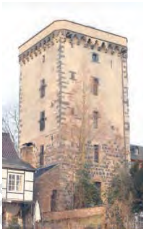
16 Der Zollturm in Zons von 1388 mit dem Wechsel von Basalt im Sockelbereich zum Tuff in den oberen Abschnitten (2019).
