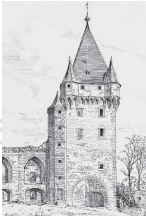
9 Zeichnung des ehemaligen Torturms der Hauptburg in Hülchrath mit der anschließenden zweiphasigen Ringmauer (links) und dem niedrigen halbrunden Bau (rechts).
