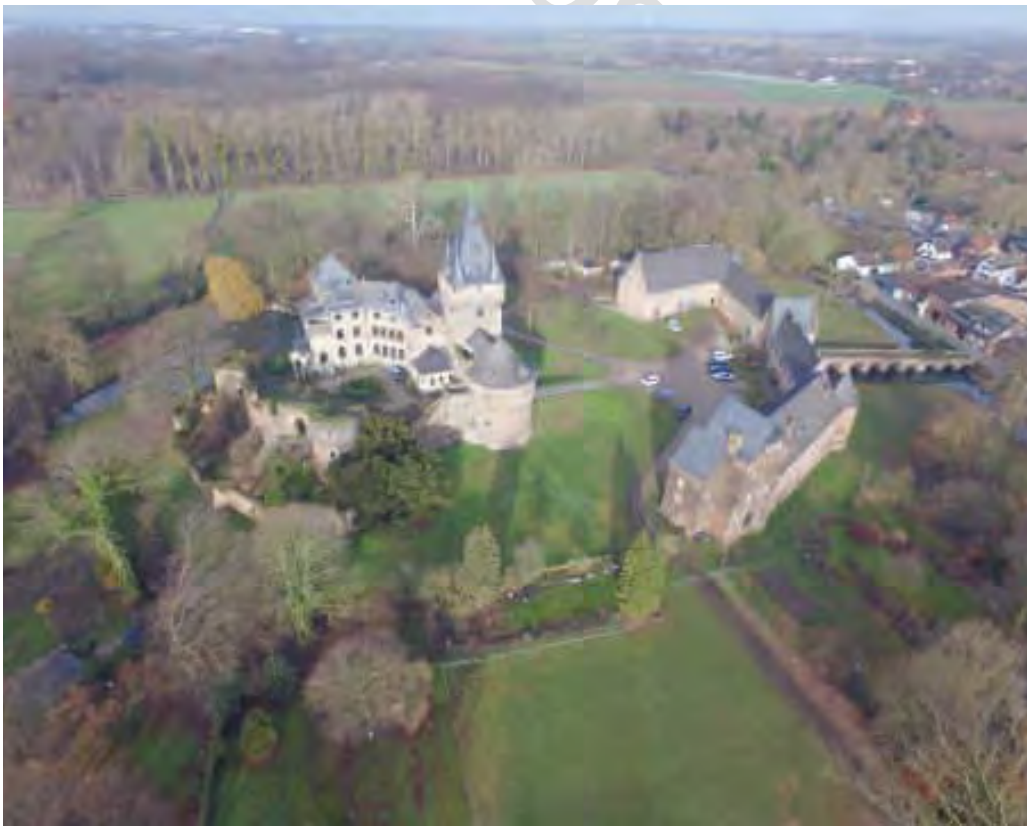
1 Luftbild der Burg Hülchrath von Osten (2019) Im Vordergrund rechts der Torturm der Vorburg (Nr. 416e).
