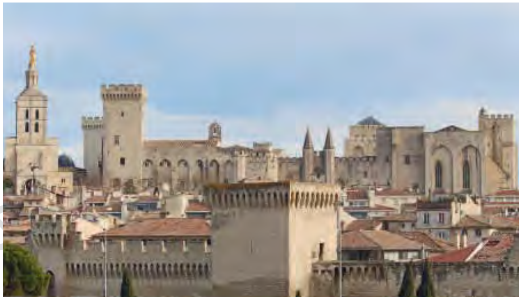
2 Der Papstpalast zu Avignon von Westen, im Vordergrund die Stadtmauer.
